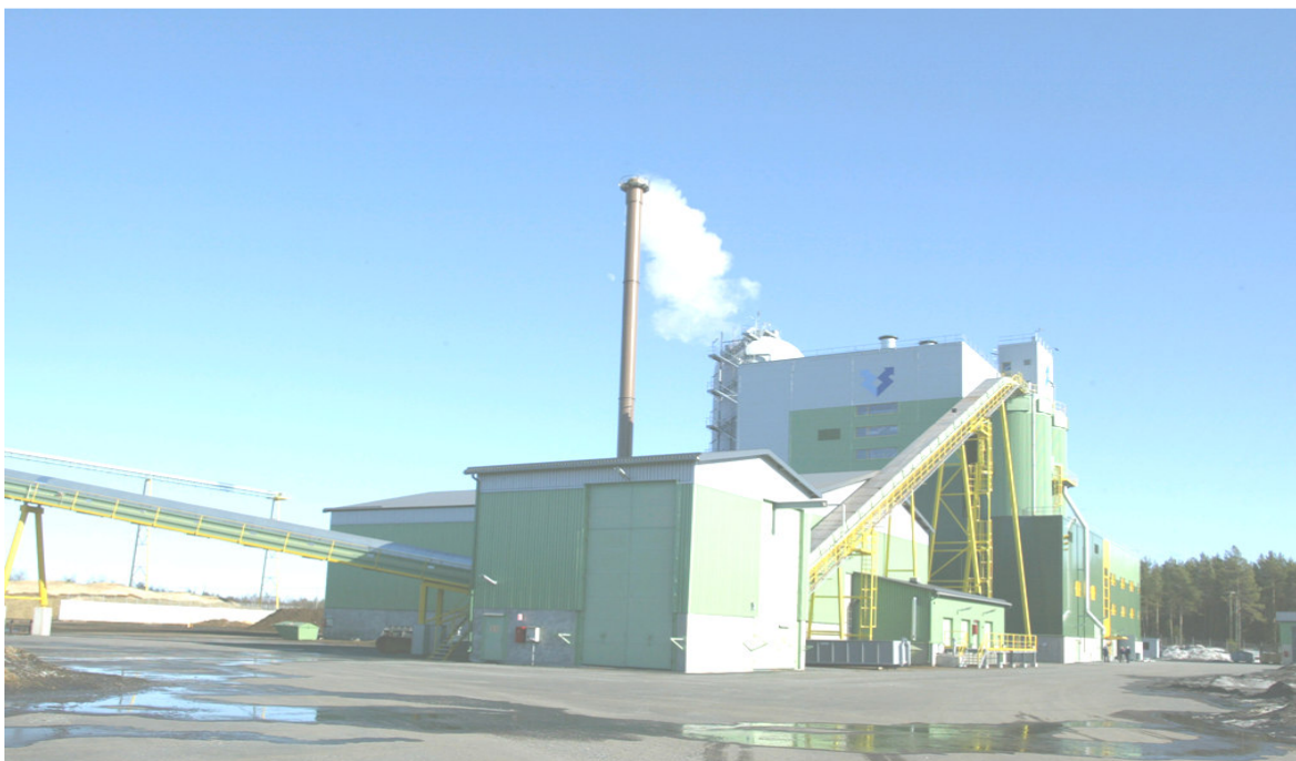
Rysunek 3. Elektrociepłownia skojarzona Kokkola Voima (moc 70 MW), Kokkola, Finlandia.
